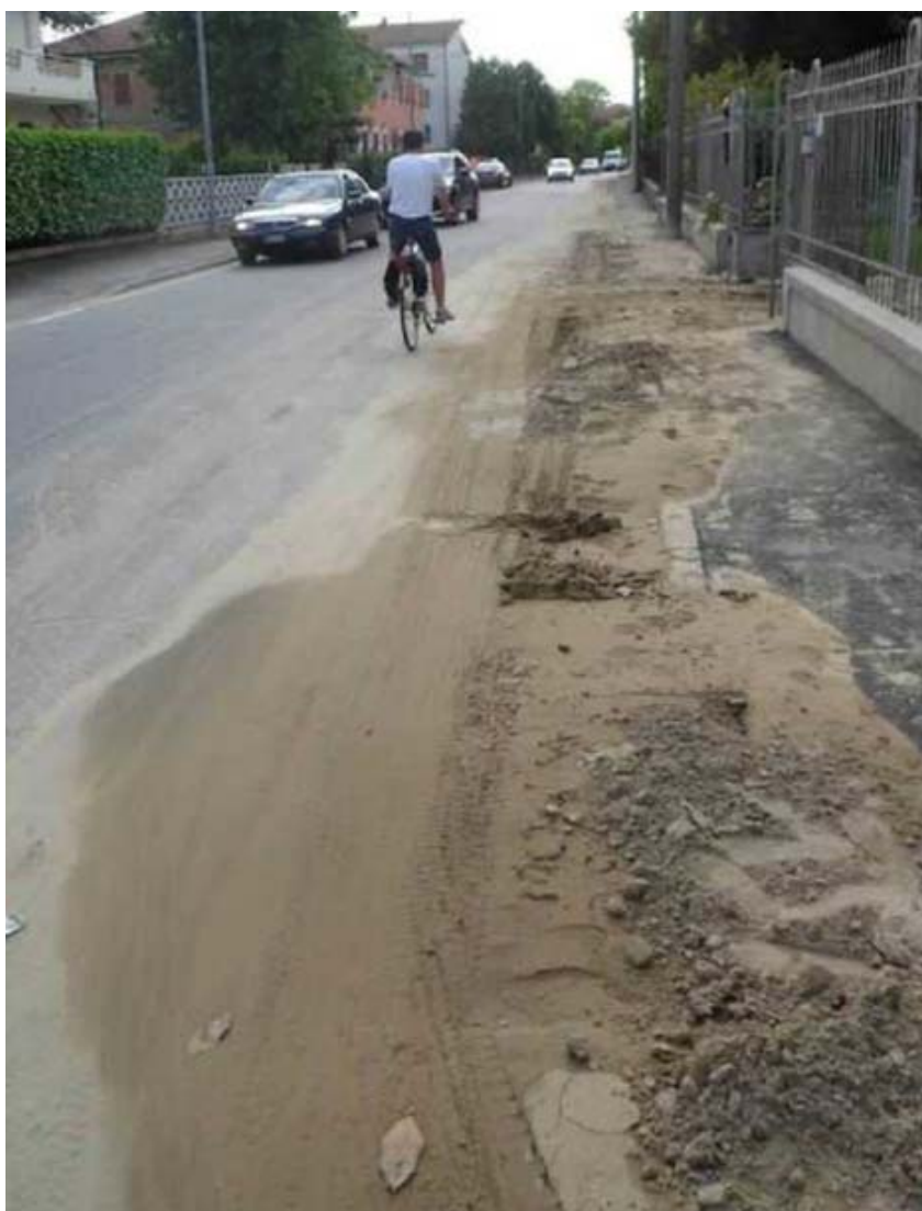
Fig. 25 – Foto raffigurante la fuoriuscita di una notevole quantità di acqua e sabbia dal cordolo del marciapiede in via Giuseppe Verdi
